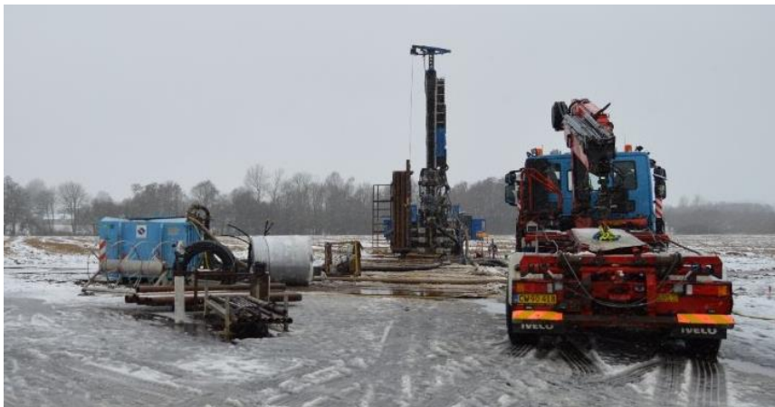
Figur 20 billede fra etablering af de tre lodrette jordvarmeboringer i Hornsyld.
