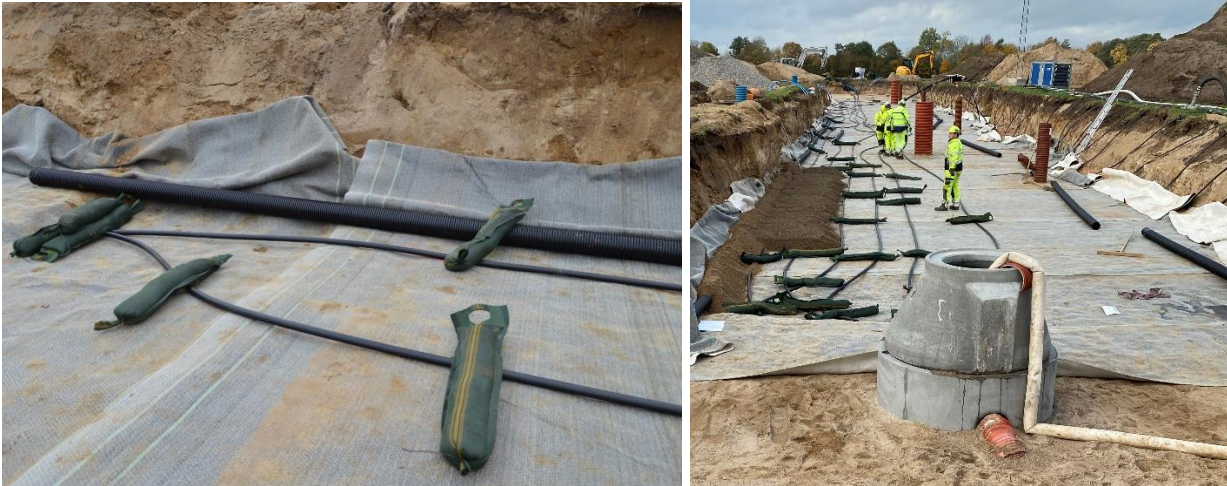
Figur 18 Ved udlægning af varmesonderne sikres placering og afstand under udlægningen, og der omkringfyldes med sand jf. beskrivelserne. Billederne her er fra udlægningen af de første jordvarmesonder, nederst i vej-kassen.
