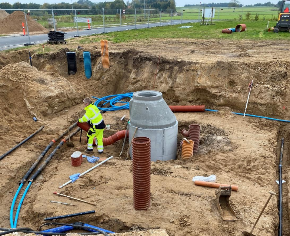
Figur 14 Arbejdet omkring betonedgangsbrønden ved udløbet af Termovejen og tilslutningen ud til forsynings ledningsnet i stamvejen.
