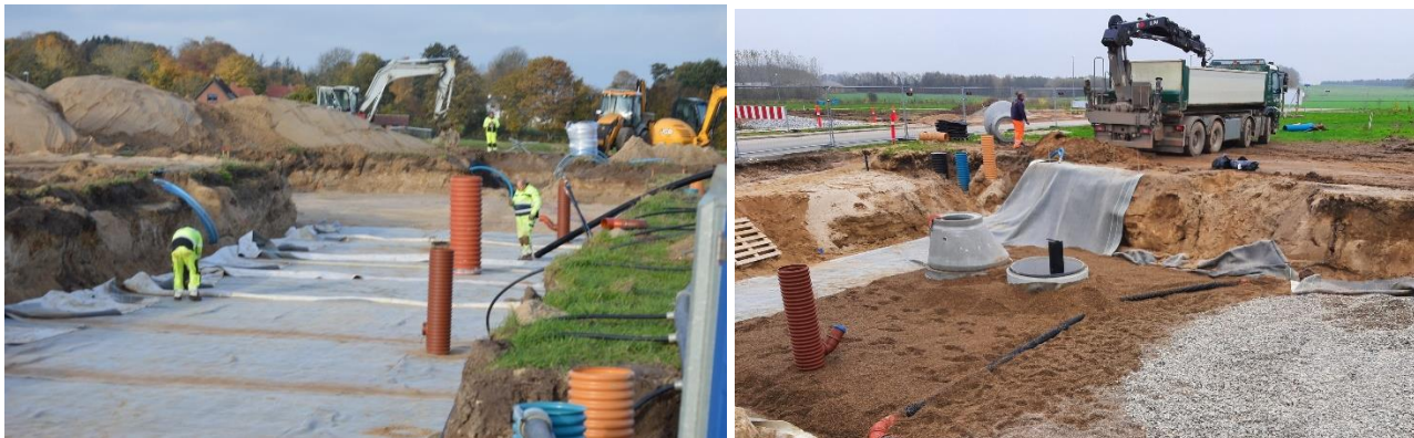
Figur 16 Ilægning af membran i vejkassen. Venstre: arbejdet i bunden af vejkassen. Højre: arbejdet senere i forløbet op langs siderne af vejkassens forløb.
